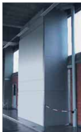
Karusely nainstalované v továrně
