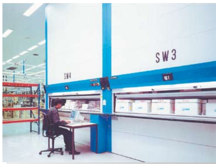
22 zařízení KARDEX Industriever® ve 4 výrobních oblastech uspoří asi 60 % dřívější skladovací plochy.
